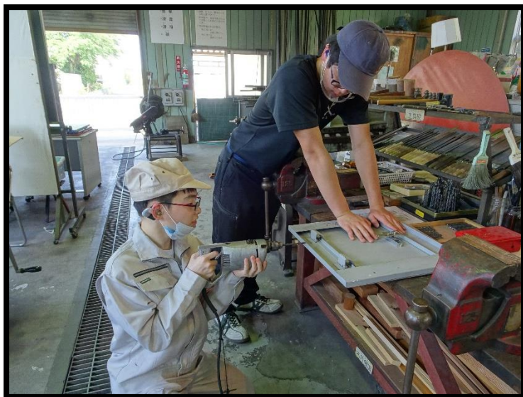
○校内 LAN ケーブル敷設の様子
